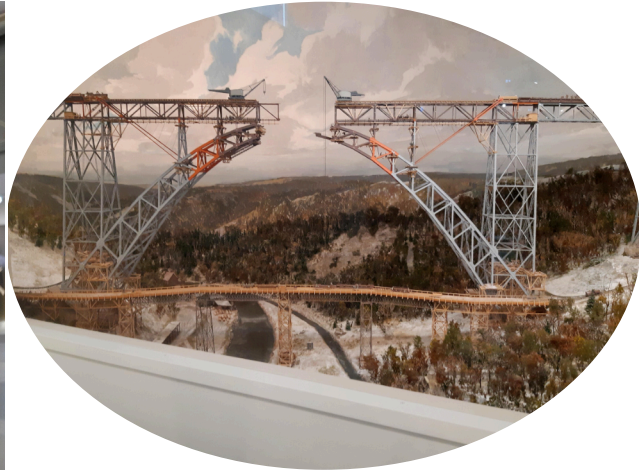
Pienoismallit olivat taidolla tehtyjä. Tässä vuosina 1893–1897 valmistuneen Wuppertalin sillan yksi kriittisistä tekovaiheista.
